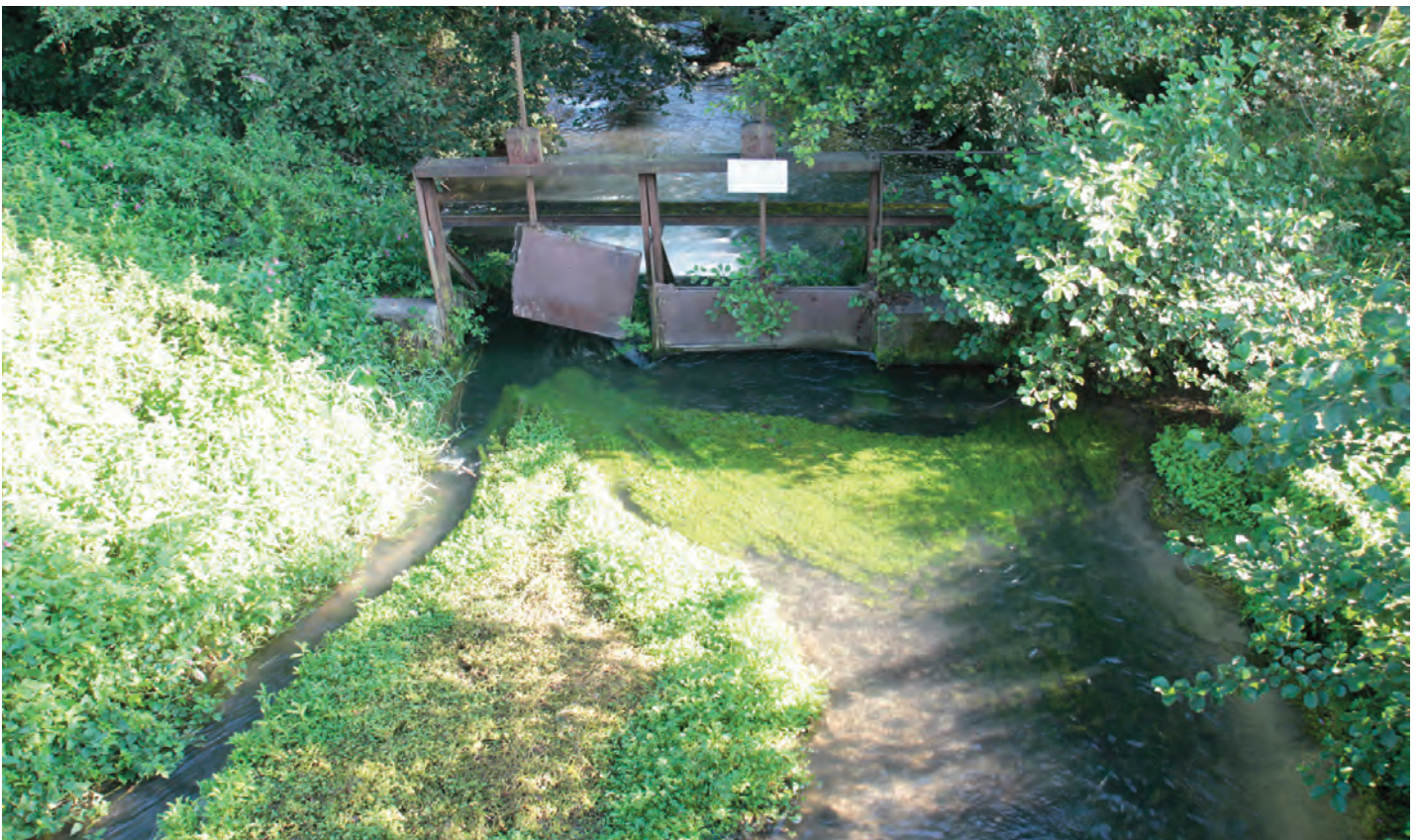
Un des nombreux biefs sur le Hoyoux permettant de disposer d'une chute d'eau en aval pour faire tourner les moulins
