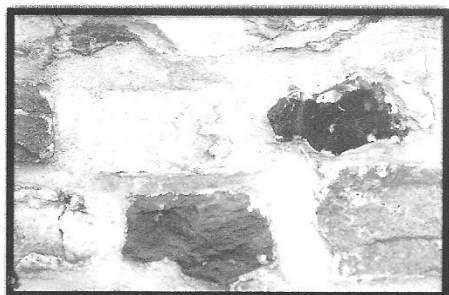
Façade de l'église d'Angre. On note la grande variété de pierres locales: calcaires récifaux très riches en coraux, grès rouges du Burnotien, silex du Crétacé.
