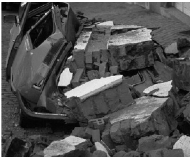
Chute de garniture en pierre et dégâts causés lors d'une secousse sismique à Liège en 1983.
