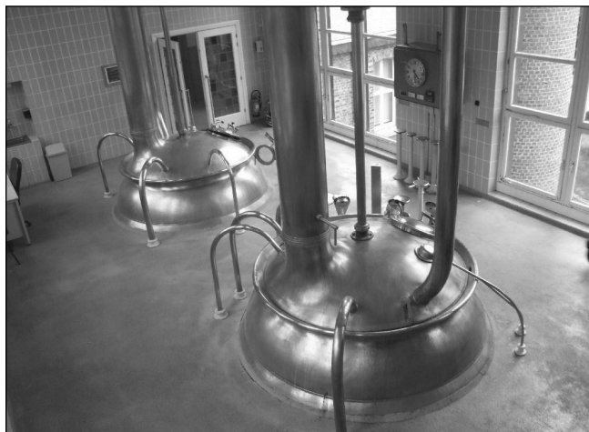
Cuves à Brassage dans l'abbaye de Rochefort directement alimentées par la source de Tridaine
