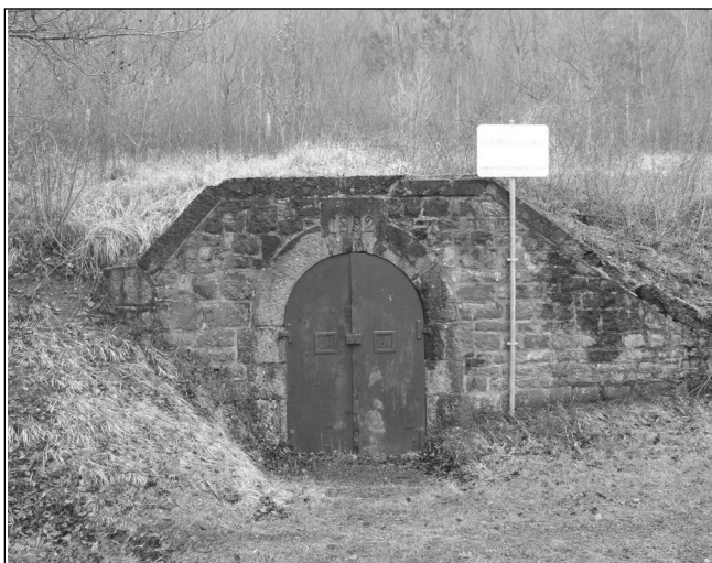
Entrée du Captage de Tridaine construit par la ville de Rochefort en 1892.
