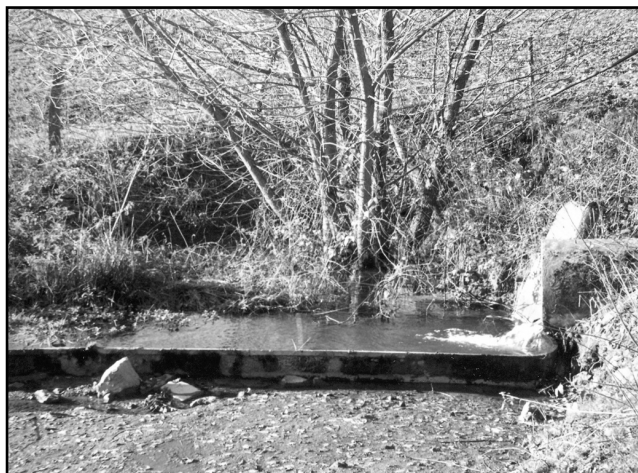
Le trop plein de l'abreuvoir se perd au contact du calcaire en amont du chantier de l'étable. Ce point de perte est donc à même de réactiver le karst de la zone en question. Le site photographié (C. Ek, novembre 2007) correspond à la perte 93 sur la carte.
