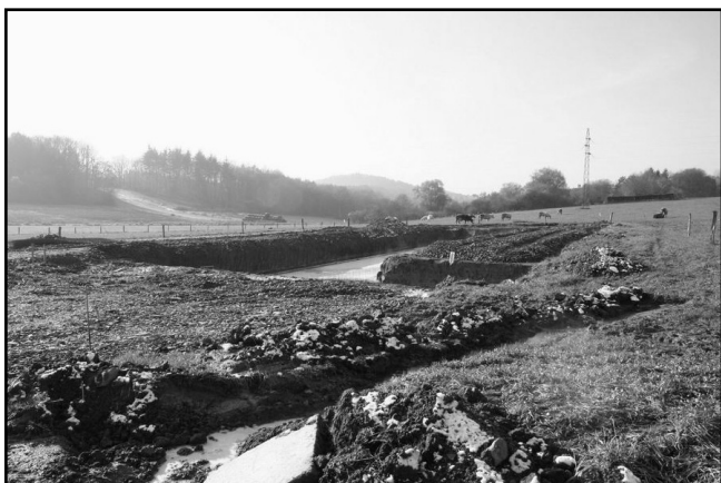
Une photo des travaux de fondation au niveau de l'étable et montrant le vallon sec en aval
