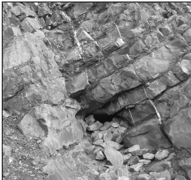
Petit conduit karstique mis en évidence dans la carrière (pt E) à l'ouest de la source de St Remy.
