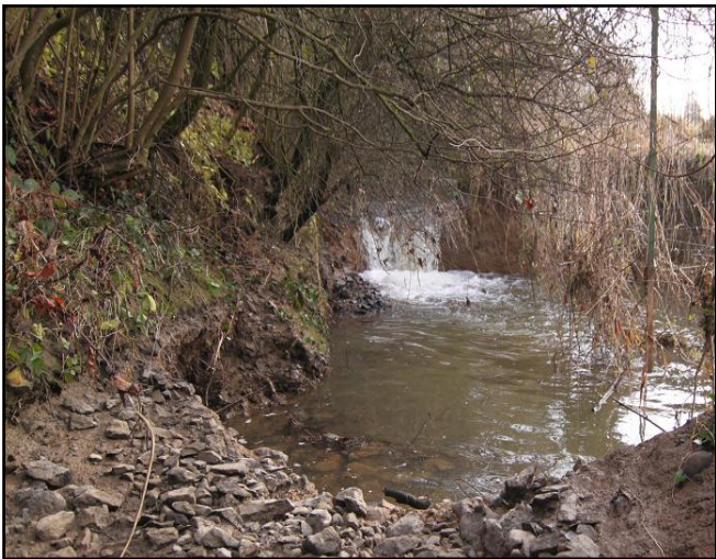
L'ouverture d'un nouvel effondrement, avec perte totale, fin novembre 2011 dans le second cours d'eau 20m plus au nord, confirmant nos craintes de voir ces phénomènes se multiplier et s'emplifier vu le déséquilibre hydrologique local (Photo R. Derrider 15 dec. 2011)
