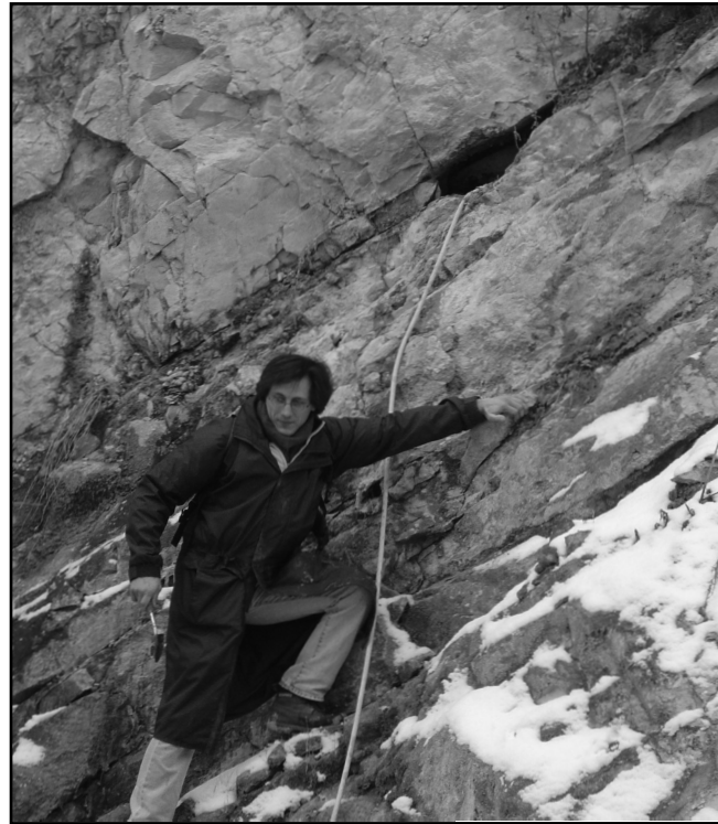
Conduit perché dans la paroi nord de la carrière 10m au-dessus du fond de l'exploitation et bouché par des chambres à air pour réduire les arrivées d'eau (Photo F. Van Dijck)
