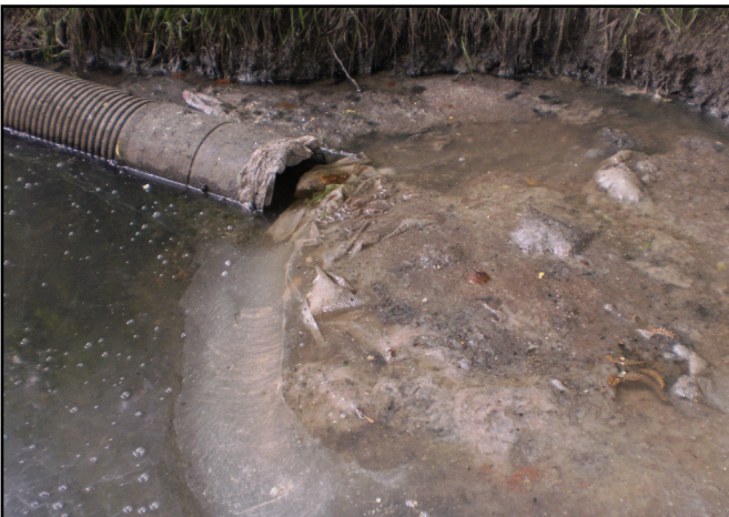
Fig. 4. Canalisation déversant eaux usées et excréments.
