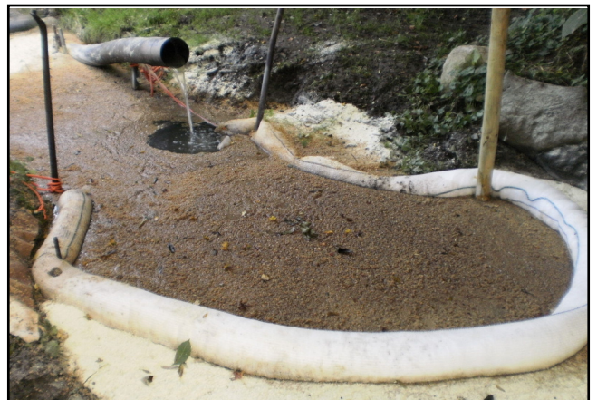
Fig. 6. Barrage flottant placé à l'aval de la conduite pour empêcher les hydrocarbures de rejoindre l'agolina (sept 2014 - Mme Degeldre)
