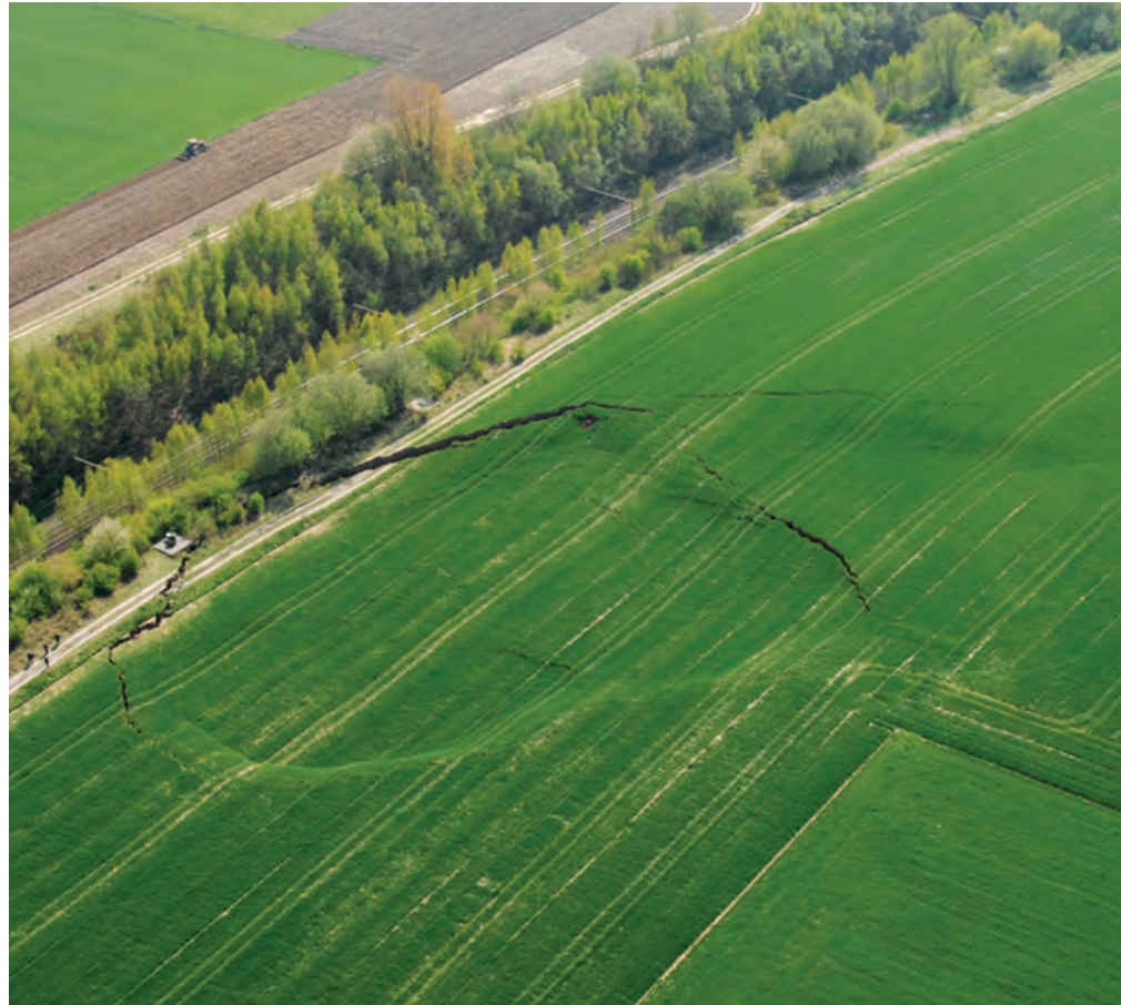
Vue générale de l'effondrement survenu le 22 avril 2015 (photo aérienne Police fédérale).
