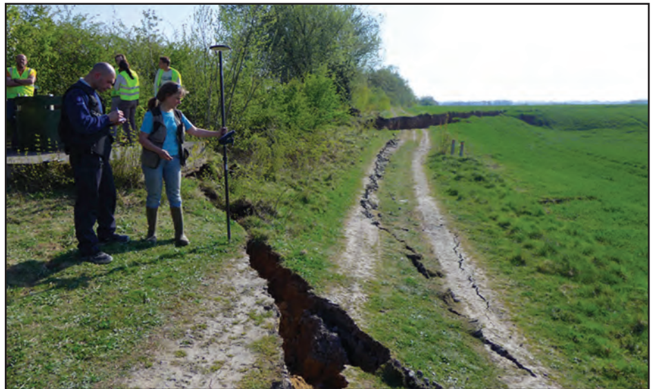
Vue du bord oriental de la cuvette, avec le réseau de crevasses. Le dénivelé est de l'ordre de 2 m par rapport à la dalle du puits n° 1 Infrabel (à l'arrière plan, à gauche).
