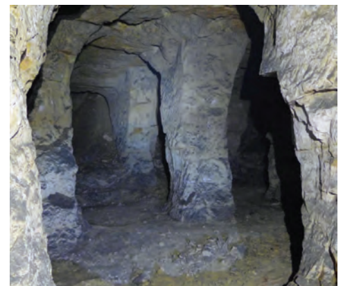
Réseaux souterrains de la Malogne, constitués d'une succession de chambres et piliers abandonnés - Partie située dans la Réserve souterraine gérée par le DNF (protection des chiroptères).
