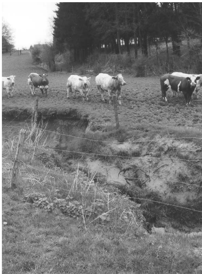
Chantoir de La Noire Fontaine à Hastière: dans cette zone de prairie connue pour son activité karstique, un double chantoir et un vaste effondrement se sont formés en 1999 (photo CWEPS 2000)
