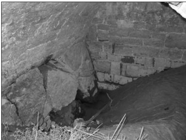
Vue à l'intérieur de la chambre de visite de la Fontaine. Le site étant à sec, on peut voir le mur maçonné qui vient s'appuyer sur la roche en place fortement corrodée et présentant une large fissure (20cm de large pour 40cm de haut) d'où sortent les eaux en temps normal. Photo CWEPPS 27 novembre 2005.
