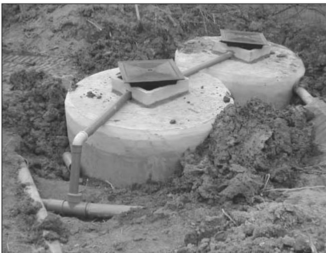
*Unité d'épuration individuelle comprenant un système de fosses sceptiques et connecté à une zone de lagunage. Ce type d'installation est efficace et bien adapté aux zones rurales où on dispose de suffisamment de place pour leur installation.*
