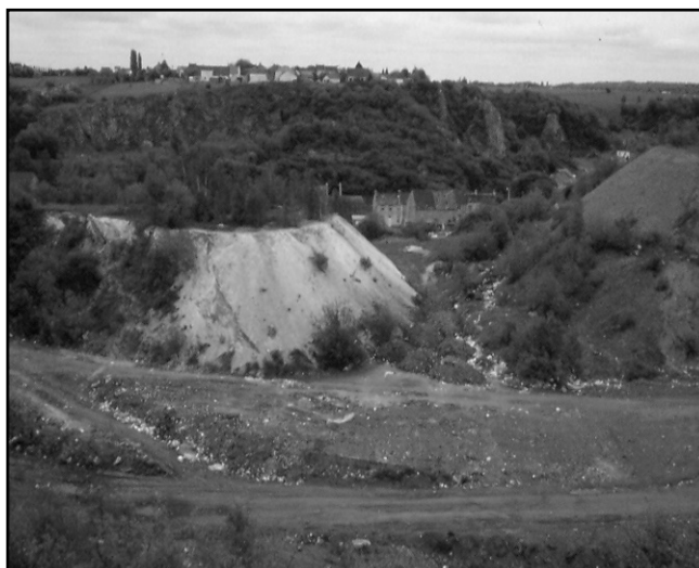
Aspect de la décharge en 1986 avant qu'elle ne soit envahie par la végétation. on y distingue des déchets de toute nature en plus des mâchefers et des cendres volantes
