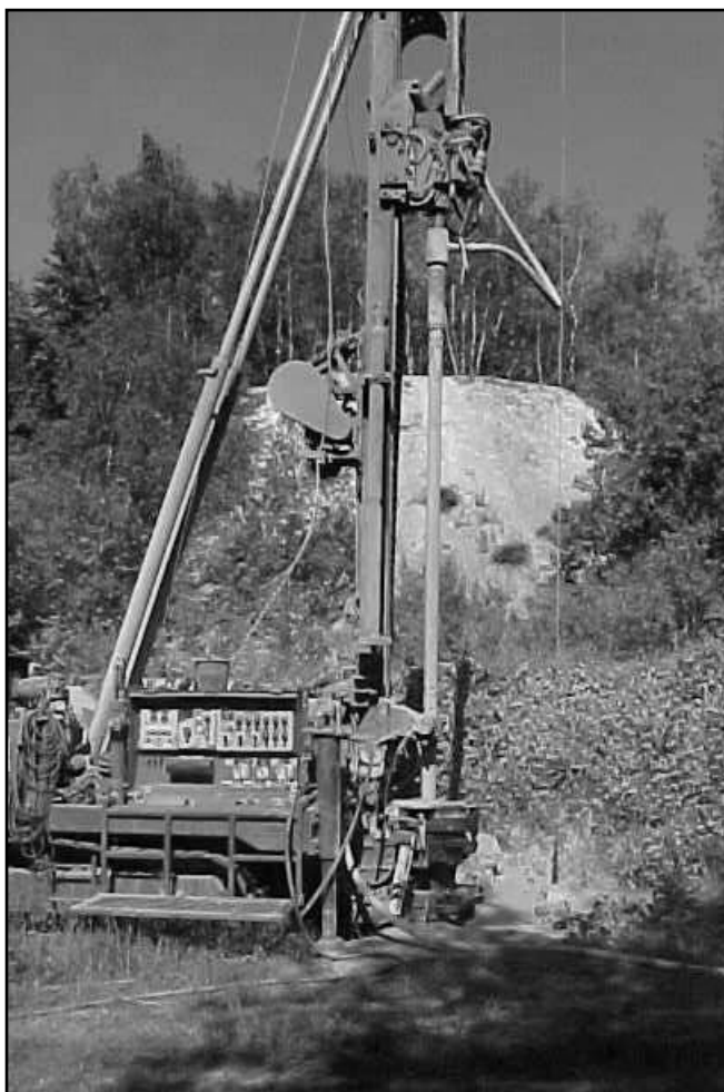
Travaux de forage entamé en juin 2006 par la SPAQuE pour pouvoir analyser l'eau de la nappe et s'assurer de l'absence de contamination depuis la décharge (photo JP Liégeois)
