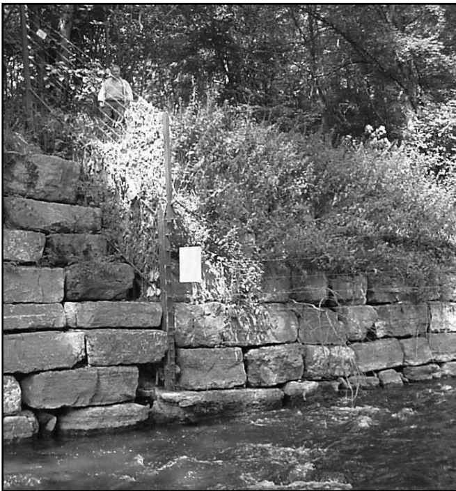
Haute clôture le long de la Lesse en amont du gouffre, empêchant tout accès aux promeneurs jusqu'au point de perte (photo CWEPPS, 2004)
