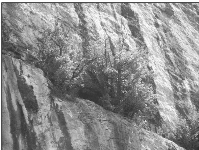
La paroi de Frênes présente de nombreuses fissures et failles élargies par la karstification qui fragilisent l'ensemble.
