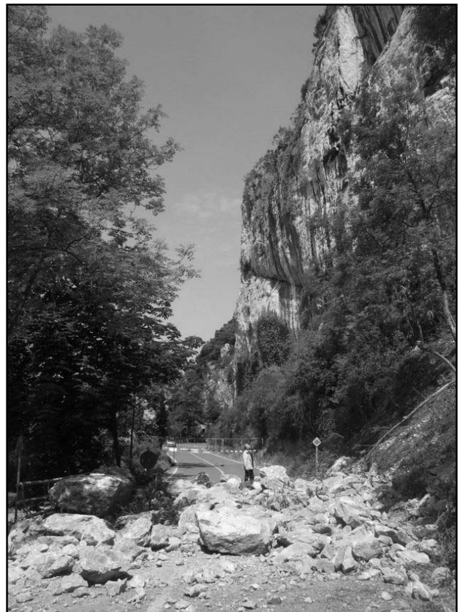
Nationale 947 jonchée de blocs provenant des parois subverticales qui forment le massif de Frênes (Photo CWEPPSS - 23 mai 2008)
