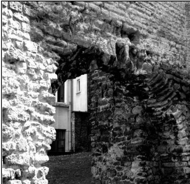
Vestiges de la première enceinte de Bruxelles (au Boulevard de l'Empereur) constitués de moellon sablo-calcaire provenant des carrières du Nord de Bruxelles
