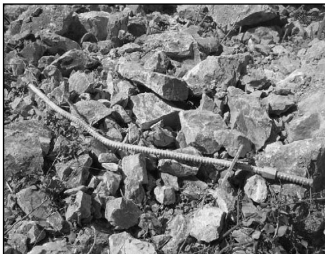
Une des broches métalliques qui devait retenir la roche. Elle a été totalement pliée et arrachée du fait de la violence de cet éboulement.
