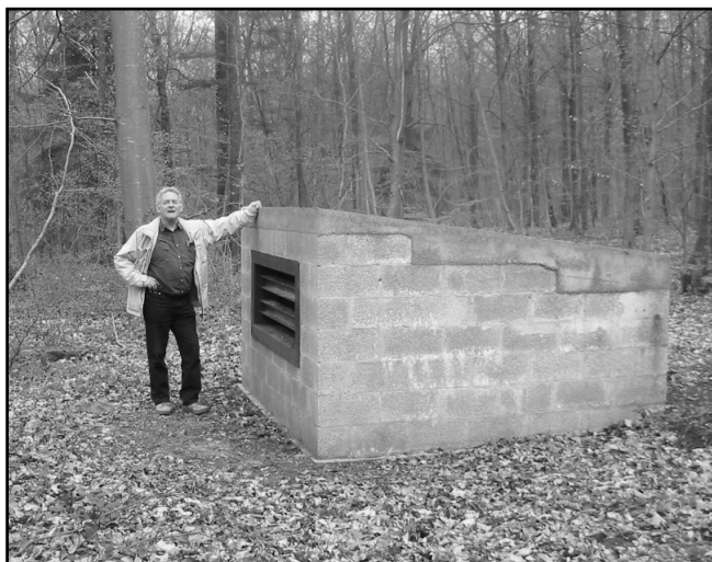
La Diaclase de Torgny, petit trou s'ouvrant à même le sol a été recouvert d'un "bunker" dans le but de protéger les chauves-souris. Ces vilains travaux ont été réalisés en pleine réserve naturelle au-dessus d'une cavité qui ne subissait quasi aucune fréquentation...
