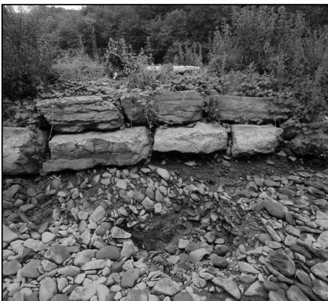
Perte partielle dans le lit de la Lomme avec affaissement de 0,8 m de profondeur dans les galets.
