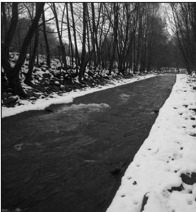
En aval de Rochefort, sur 100 m, le lit de la Lomme est rectiligne et bétonné pour éviter les pertes dans les aiguigeois de la route de Han – pt B (photo en décembre 2010)
