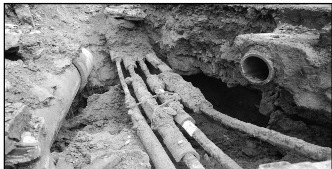
Réseau de câbles et de conduits mis à nu par l'affaissement. La présence de ces "impétrants" sont une contrainte supplémentaire.
