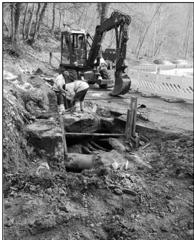
Ouverture de l'effondrement par la commune le 13/02/2013 pour estimer l'extension de l'effondrement et réparer les canalisations.
