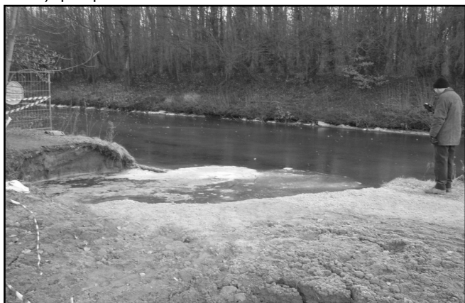
Effondrement du Canal (A1) formé en janvier 2006 et ayant contaminé la nappe avec de l'eau du canal (Photo C. Havron).
