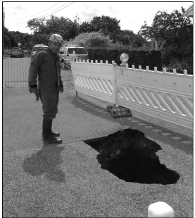
Photo 3 - fontis perçant la rue Prince Baudouin à Heusy, suite à la rupture de l'égout ayant provoqué un important soutirage.
