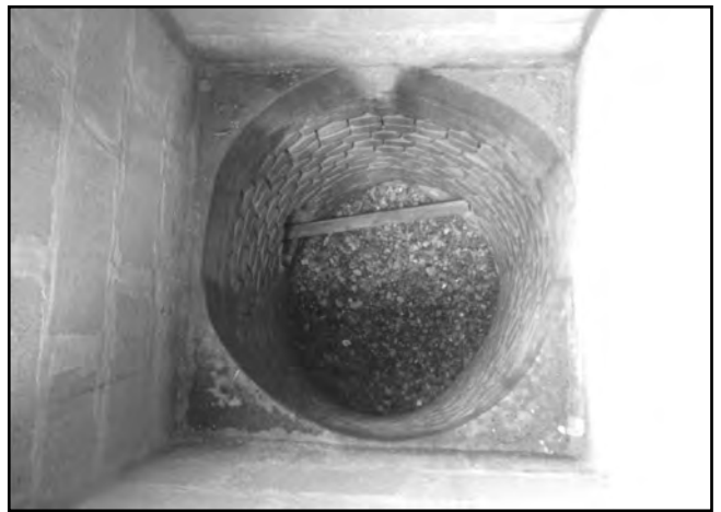
Photo 2. Puits aménagé dans le fond d'un agolina pour permettre l'infiltration des eaux de ruissellement lors des crues.
