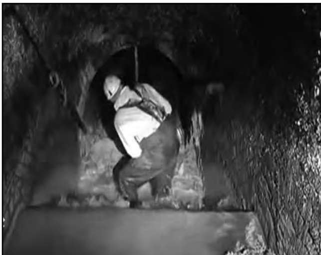
Le réseau d'égouts de Londres date du 19 e siècle. Certains collecteurs ont été bouchés à 95% par l'accumulation de graisses d'origine alimentaire!
