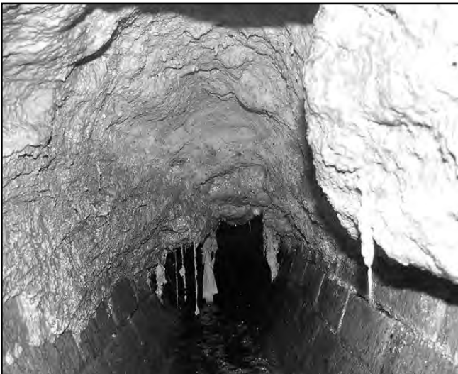
Conduit d'égout londonien prenant presque l'allure d'une grotte avec ce concrétionnement adipeux fixé à la voûte... Mais l'odeur ne trompe pas quant à la nature de ce matériel précipité.
