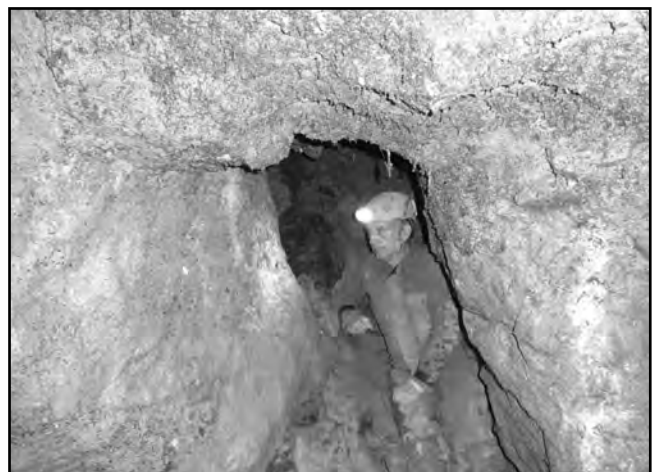
Photo 4. Trou du prince Baudouin, l'affaissement du tablier de la route donne accès à une vertibale petite cavité aux parois indurées.
