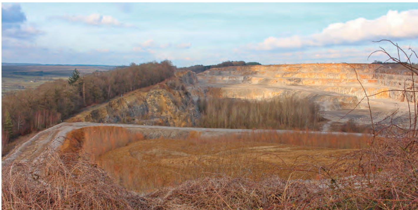
La carrière de la Boverie descend actuellement jusqu'à la cote 220 m. Le drainage de la galerie de Tridaine se situe à gauche de la photo, dans le versant, à la base de la zone forestière (cote 211 m).
