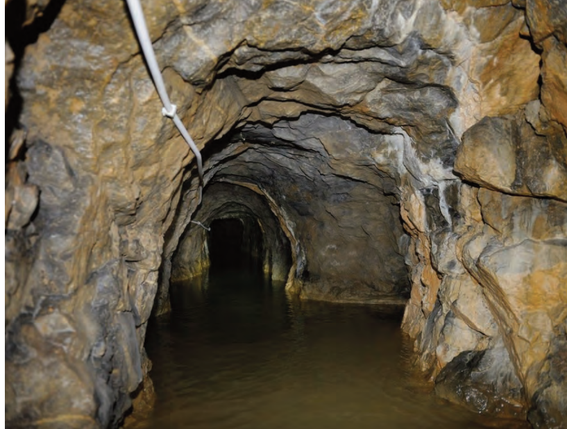
Dans l'ancienne galerie de mine, plusieurs griffons drainent l'aquifère pour alimenter le captage de Tridaine.
