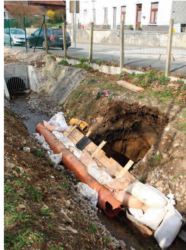
Fig. 5. Aménagement placé en urgence par la commune de Gerpinnes le 16 mars 2019, pour limiter la perte et le soutirage.
