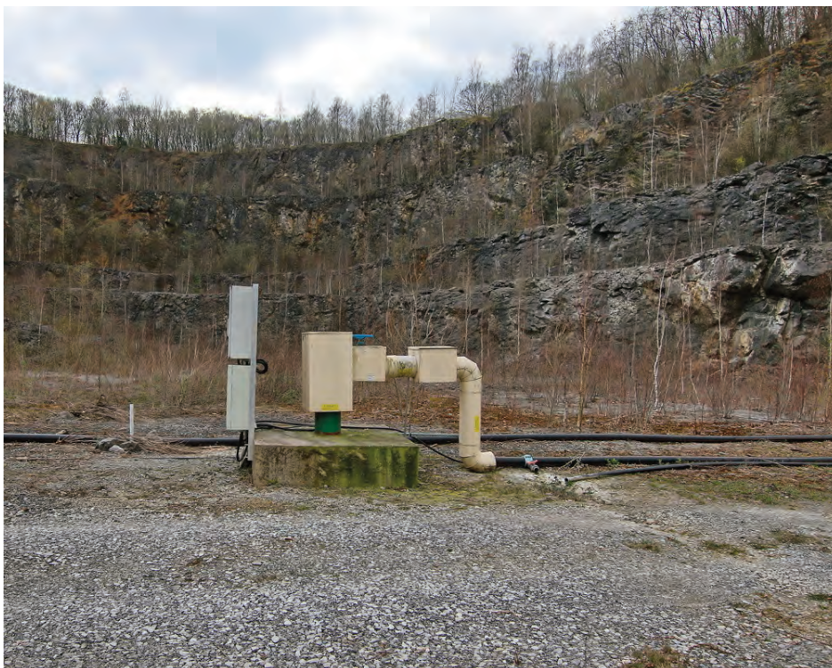
Fig. 4. Le forage PR 3 dans le fond de l'ancienne carrière (altitude 110 m) est équipé de pompes puissantes pour contenir la nappe affectée par les chlorures.
