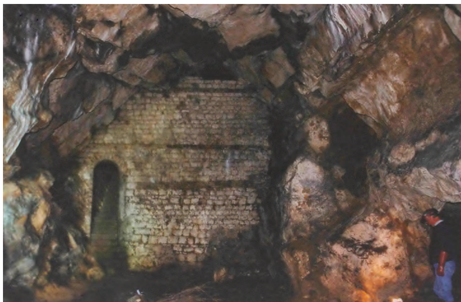
Le mur de la glacière barre la cavité, à mi-chemin avec l'escalier d'accès au haut de la cuve.
