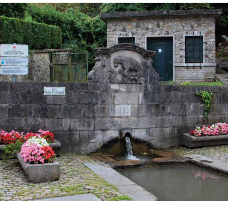
Fig. 3. La Fontaine des Ours. Emergence karstique au contact entre les calcaires et les schistes houillers et aménagée en captage (SWDE - voir flèche bleue sur la fig 5).
