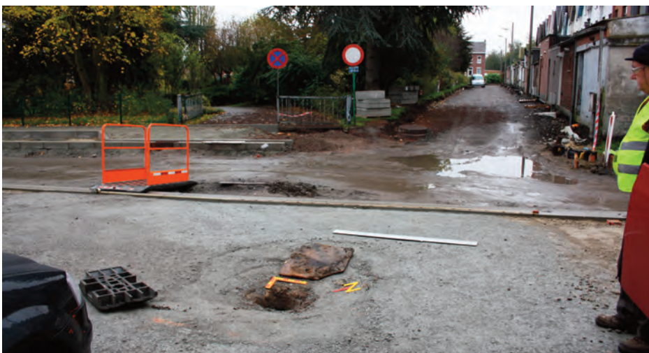
Orifice percant le tarmac suite aux travaux de voirie rue Appomée (photo E. Verardo 03/11/2019).
