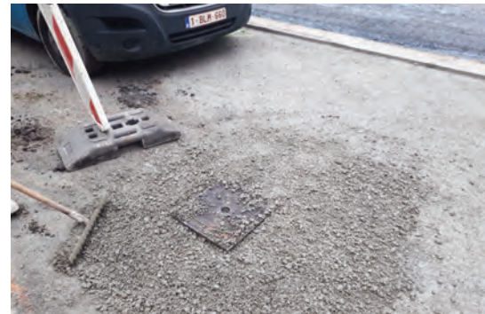
Réparation réalisée par le service travaux de la commune. Une taque de 30cm de côté recouvre l'ouverture... elle est nettement moins large que le puits maçonné
