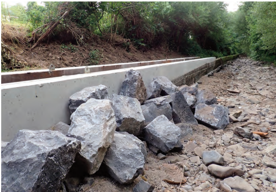
Fig 5. Section de l'aqueduc dans le lit à sec de la Wamme, récemment réparée (nouveau coffrage) par la société Lhoist pour limiter les infiltrations d'eau et garantir un débit aérien minimum en direction de la Lomme
