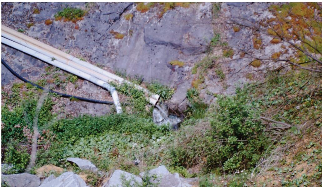
Fig. 4. Les différents tuyaux déversant les eaux usées dans la fissure karstique de la carrière d'Anthisnes. Photo CWEPS 1987, avant que cette partie de l'exploitation ne soit remblayée.
