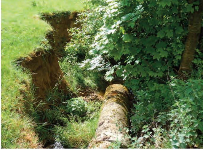
Photo 02. La canalisation des eaux de la Noire fontaine pour faciliter le passage du bétail et limiter le soutirage n'a pas résisté. Les eaux s'en échappent et reprennent leur travail de sape (photo JPL, Mai 2022).
