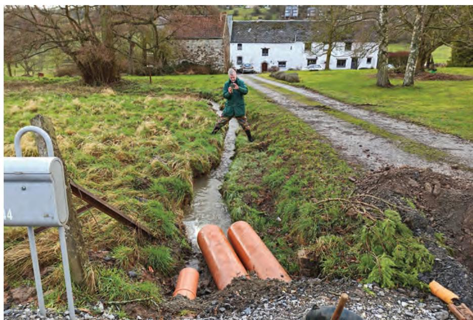
Fig. 8. Le chantoir de la Coloration, voit plusieurs canalisations à hauteur de la rue Fond de Vau, se déverser vers le calcaire et les points de pertes. Il s'agit là encore d'un mélange d'eau de ruissellement, de sources provenant des grès et d'eaux usées. La concentration des polluants variant nettement selon les saisons par effet de dilution.
