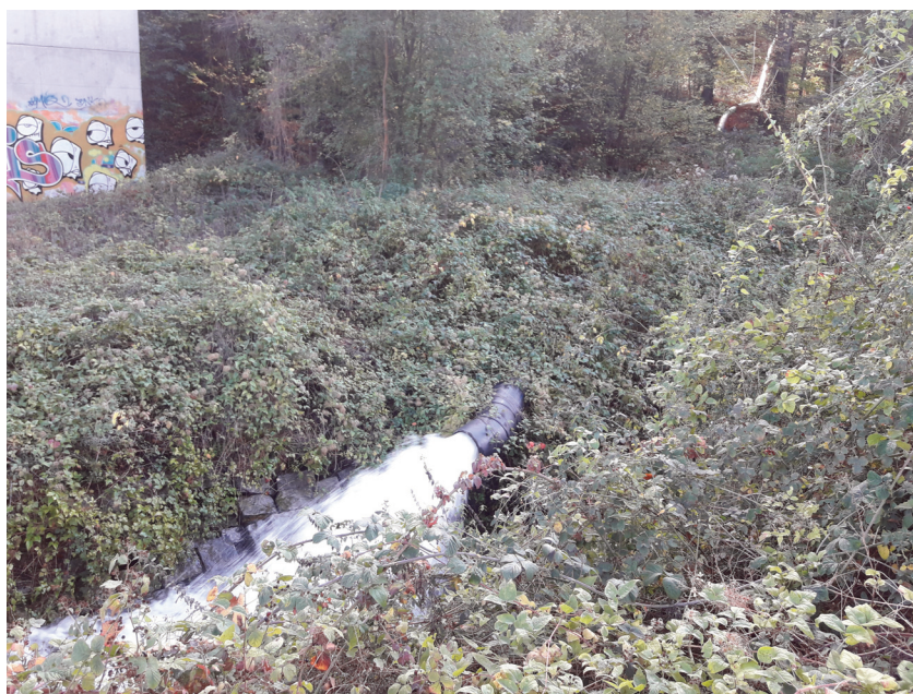
Fig. 12. Les pompages temporaires réalisés dans le “Lac de la carrière Est, pour en régler le niveau, se déversaient via un large tuyau juste à hauteur du viaduc (Photo L. Funcken, octobre 2017).
