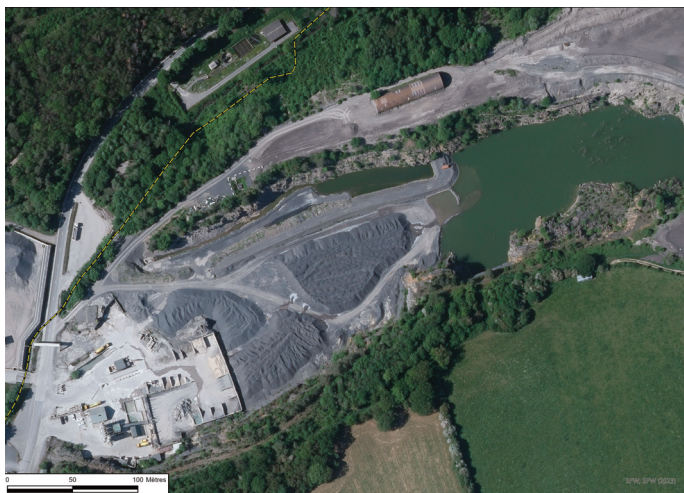
Fig. 6. Vues aériennes de la carrière Est comparant la situation en mai 2012 (haut) et en mai 2023 (en bas). Le "lac" s'est nettement étendu entre ces deux dates.
