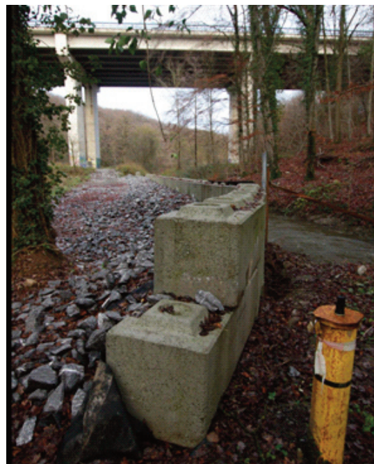
Fig. 14. Pour limiter les pertes successives en rive gauche du Ry d’Ave et les débordements vers cette zone déconsolidée, le SPW MI a dressé un mur de berge en blocs de béton empilables, haut de 1,5 m, depuis le gué jusqu’aux piles du viaduc. Le dispositif a résisté aux crues de juillet 2021.
