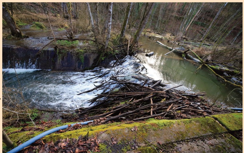
Fig 8. Le barrage aval construit par le castor à hauteur de l'ancien captage communal, provoque une hausse du niveau d'eau de près d'un mètre à l'amont.
