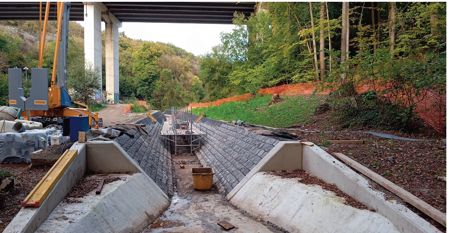
Fig. 1. État d'avancement des travaux de canalisation et d'imperméabilisation au 1er octobre 2025 dans le lit du Ry d'Ave, entre le gué et le viaduc de l'autoroute E411 (Photo G. Michel).
